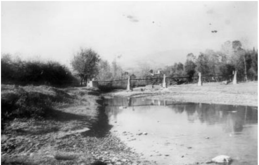
Il "Ponte a catena" dopo i lavori di ricostruzione in cemento dei piloni di sostegno a seguito degli ingenti danni provocati nel 1929 da una devastante piena (Foto anni Trenta).
