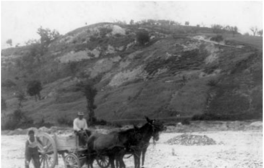
I carrettieri al lavoro sul Vezzola per ricavare ghiaia e sabbia da portare nei cantieri edili della città (Foto anni cinquanta. Cortesia di Umberto Ranalli).
