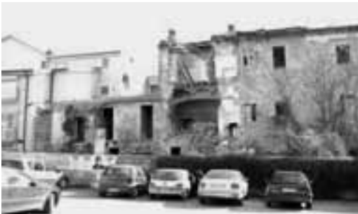
Foto I - Attorno al Teatro romano: resti delle demolizioni del Piano di S.M. a Bitetto.
