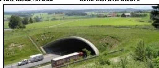
Fig.12 Ponte verde, autostrada E43, Gebrazhofen, Germania
