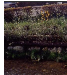
Fig. 4 Sponda palificata e fascine di salice
