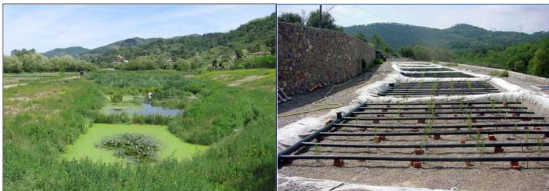
Figura 4a. Sistemi di fitodepurazione: a sinistra panoramica impianto a servizio del Comune di Dicomano (3.500 AE), a destra impianto a servizio della Frazione di Olle (200 AE) Comune di Finale Ligure, tratto da ISPRA "Guida Tecnica per la Progettazione e Gestione dei sistemi di fitodepurazione per il trattamento delle acque reflue urbane".
