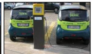
Fig.7 Colonnina di ricarica per i mezzi elettrici
