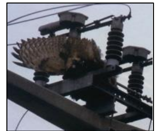
Fig.7 Tralicci con isolanti
