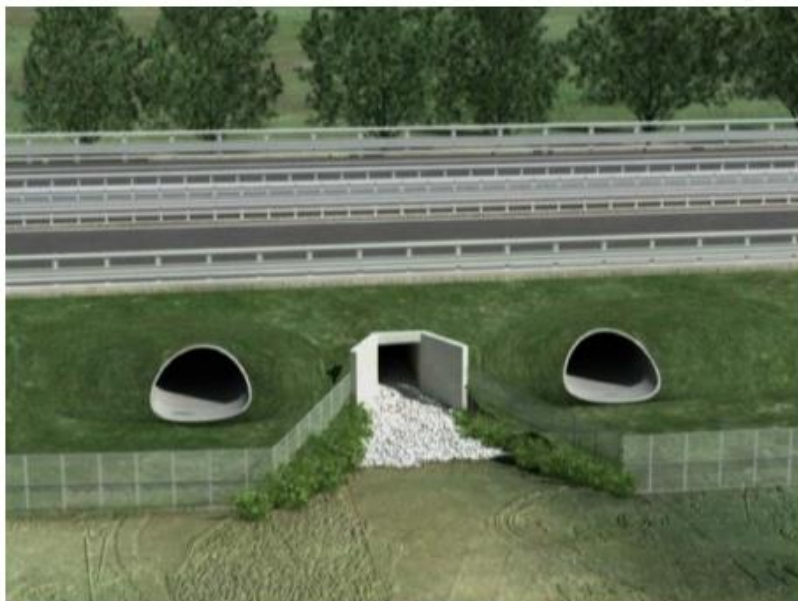
Fig.2- Sottopassi ad esclusivo uso faunistico (da www.arpa.piemonte.it )
