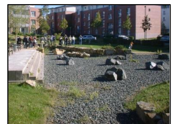
Fig. 6 Sistema di raccolta ed infiltrazione delle acque (Ecovillaggio di Kronsberg ad Hannover)
