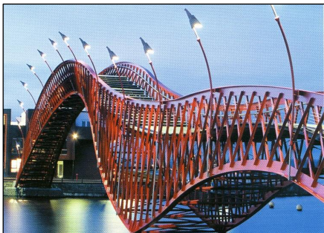
Fig.1 Ponte in ambito urbano (landmark)
