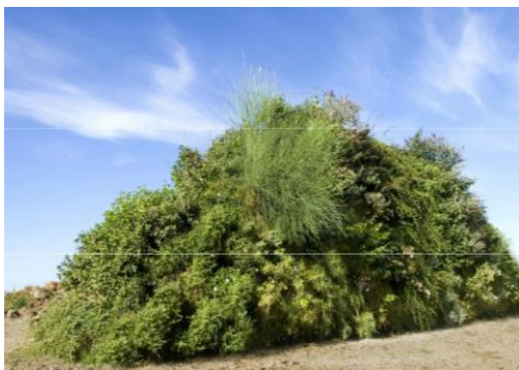
Fig.4. Barriera antirumore vegetata ad arbusti in terrapieno complesso in struttura metallica. Tratto da "Linee Guida Strade", Prov. Bologna
