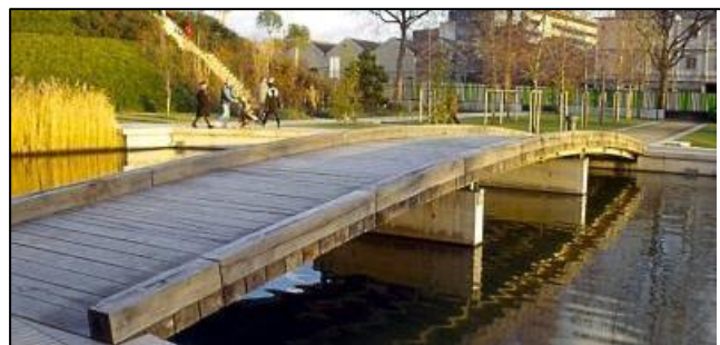
Fig.2 Ponte in ambito periurbano
