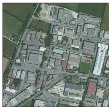
Fig.8 Grandi edifici produttivi in insediamenti di pianura (Torbole Casaglia, BS)
