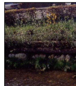
Fig. 4 Sponda palificata e fascine di salice
