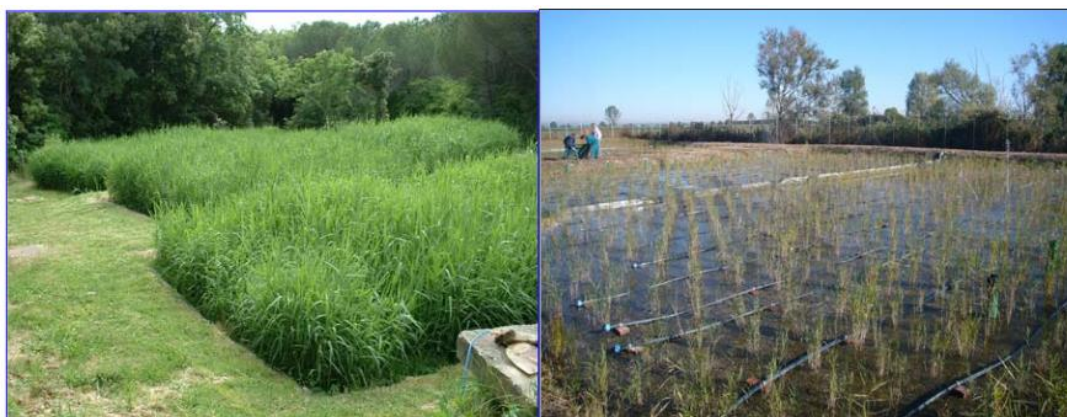
Figura 4b. Sistemi di fitodepurazione al servizio di Cantine costituito da un sistema a flusso orizzontale a sinistra e da un sistema a flusso libero a destra: tratto da ISPRA "Guida Tecnica per la Progettazione e Gestione dei sistemi di fitodepurazione per il trattamento delle acque reflue urbane".
