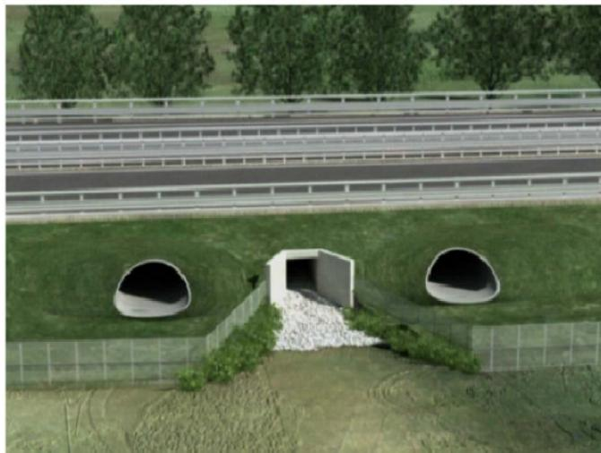
Fig.2- Sottopassi ad esclusivo uso faunistico (da [www.arpa.piemonte.it](http://www.arpa.piemonte.it))
