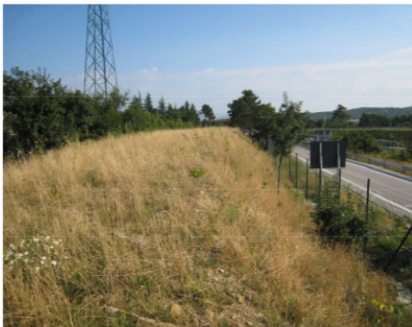
Fig.1-GVT (TS) terrapieno vegetato di isolamento strada, tratto da "Linee Guida Strade", Prov. Bologna
