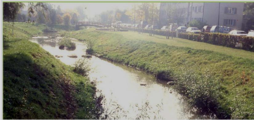
Fig.5. Rinaturalizzazione delle sponde in Ambito Urbano da " Repertorio delle misure di mitigazione e compensazione paesistico ambientale -Adeguamento Piano Provinciale di Milano".
