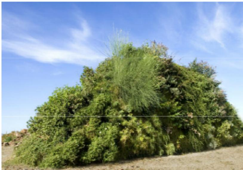
*Fig.4. Barriera antirumore vegetata ad arbusti in terrapieno complesso in struttura metallica.
