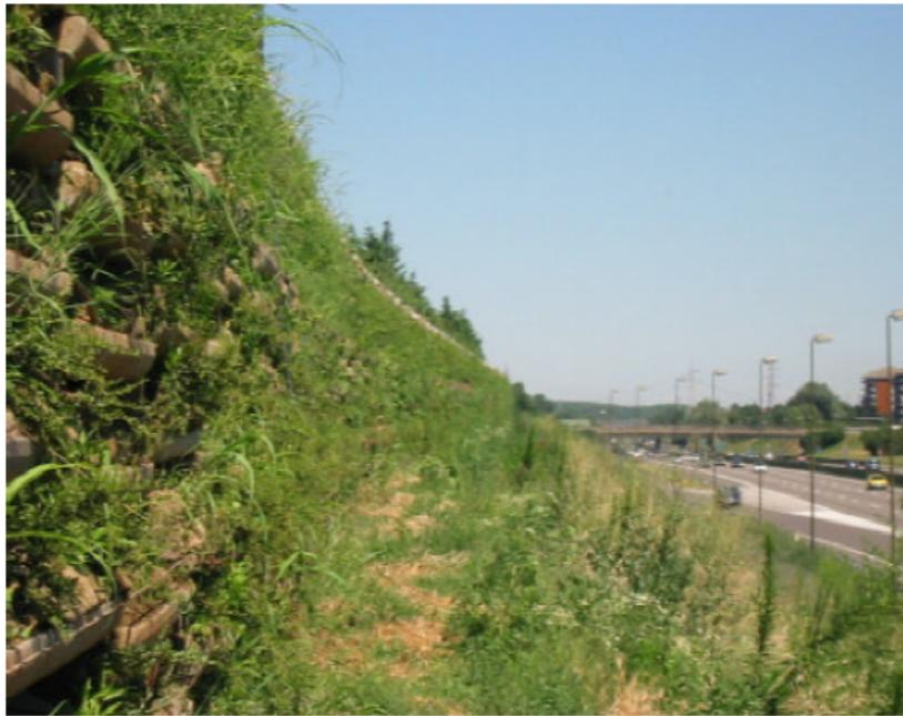
*Fig.3. Barriera antirumore in cls vegetata. Tratto da "Linee Guida Strade", Prov. Bologna*
