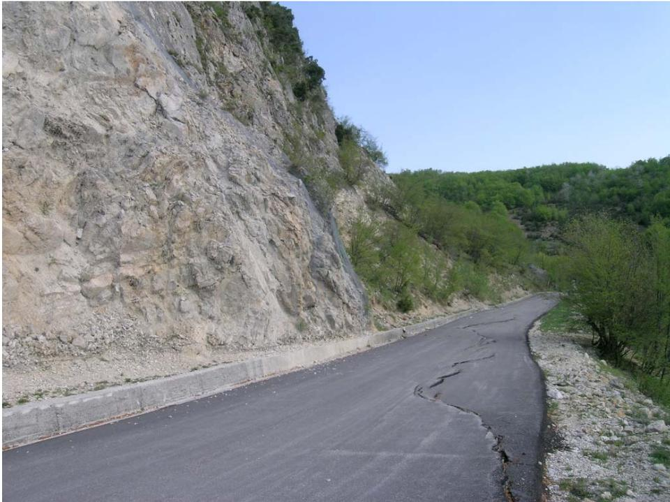
*Fig. 4 – Evidenza di attività recente della frana in destra del T. Salinello.*
