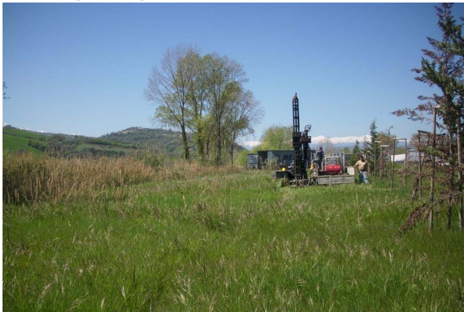
Postazione di sondaggio: S1 - Località: Z.I. Castelnuovo al Vomano - Castellalto (TE)
