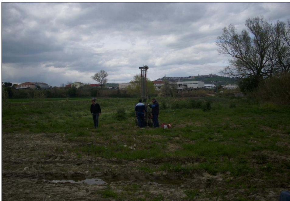
Postazione Prova Penetrometrica: CPT.3 - Località: Sp sx Fiume Vomano - Roseto degli Abruzzi (TE)
