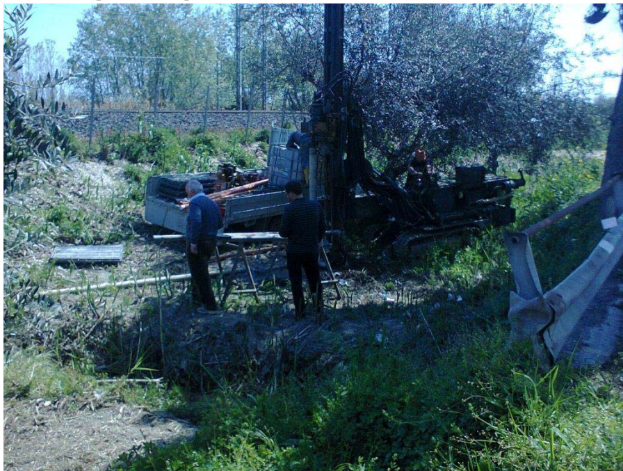
Postazione di sondaggio: S5 - Località: Scerne, SS 16 Km 423+V - Pineto (TE)
