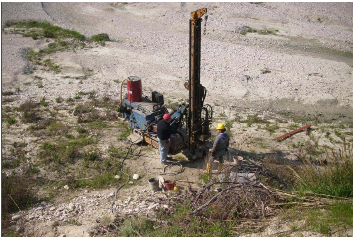
Postazione Sondaggio S2, località Stracca, sd.dx Fiume Vomano (16.04.2013)
