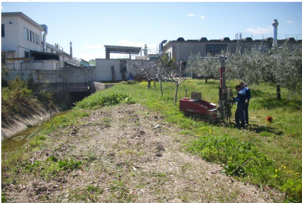
Postazione Prova Penetrometrica: CPT.2 - Località: Sp dx Fiume Vomano - ZI Scerne - Pineto (TE)
