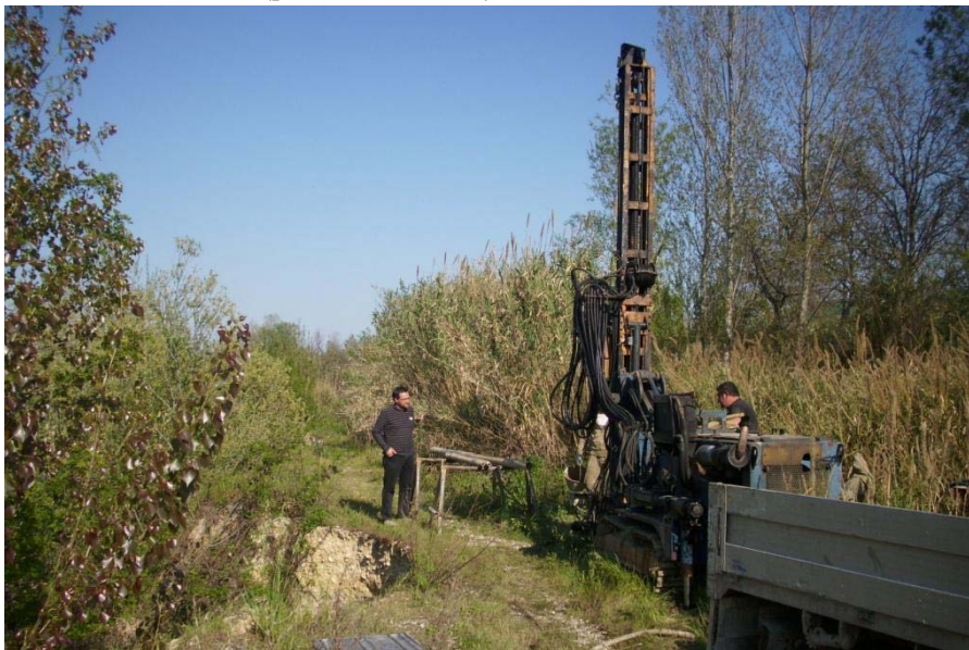
Postazione di sondaggio: S6 - Località: Fontanelle - Atri (TE)
