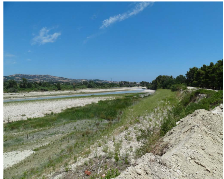
Foto 06 – Sponda da proteggere
