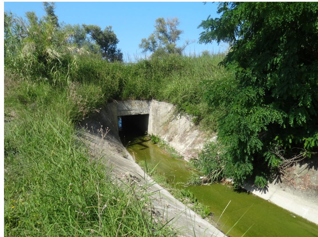
Foto 20 – Immissione canale nell'argine
