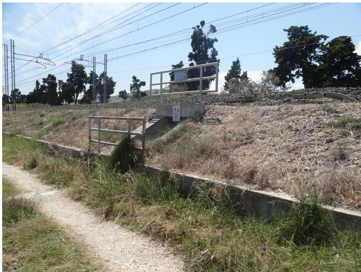
Foto 10 – Attraversamento esistente Ferrovia (lato mare)
