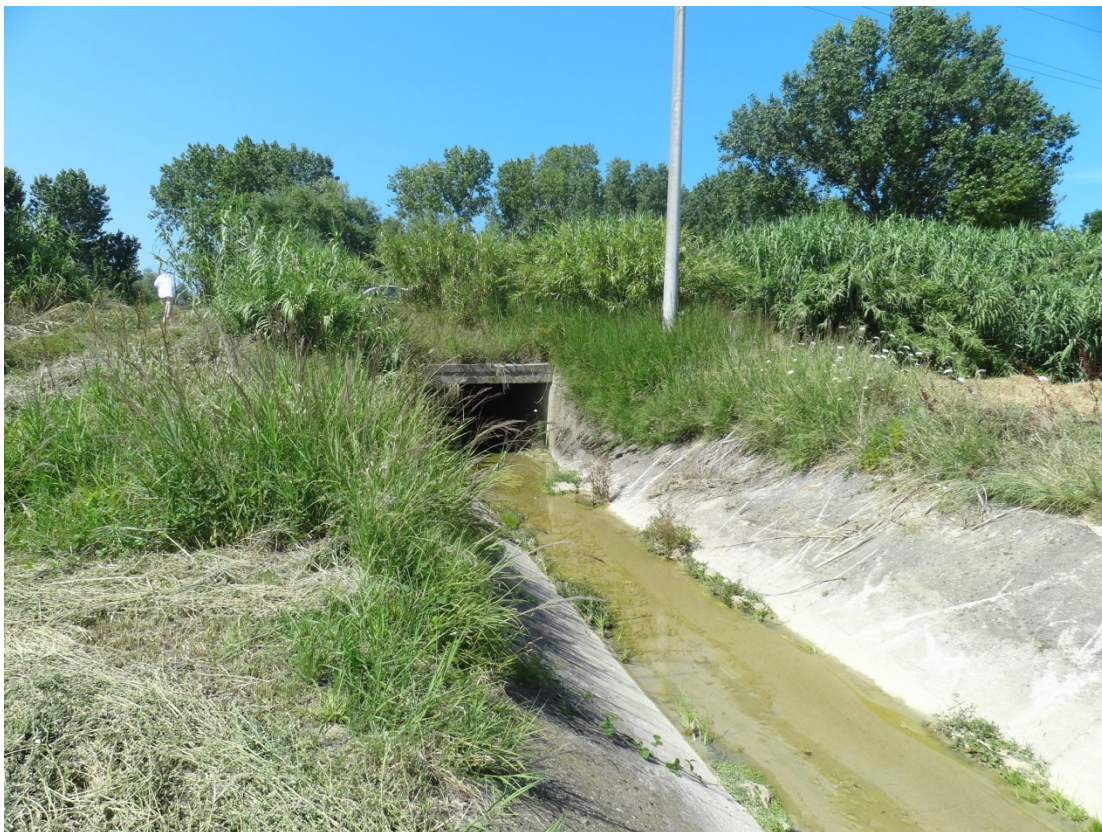
Foto 19 – Immissione canale nell'argine
